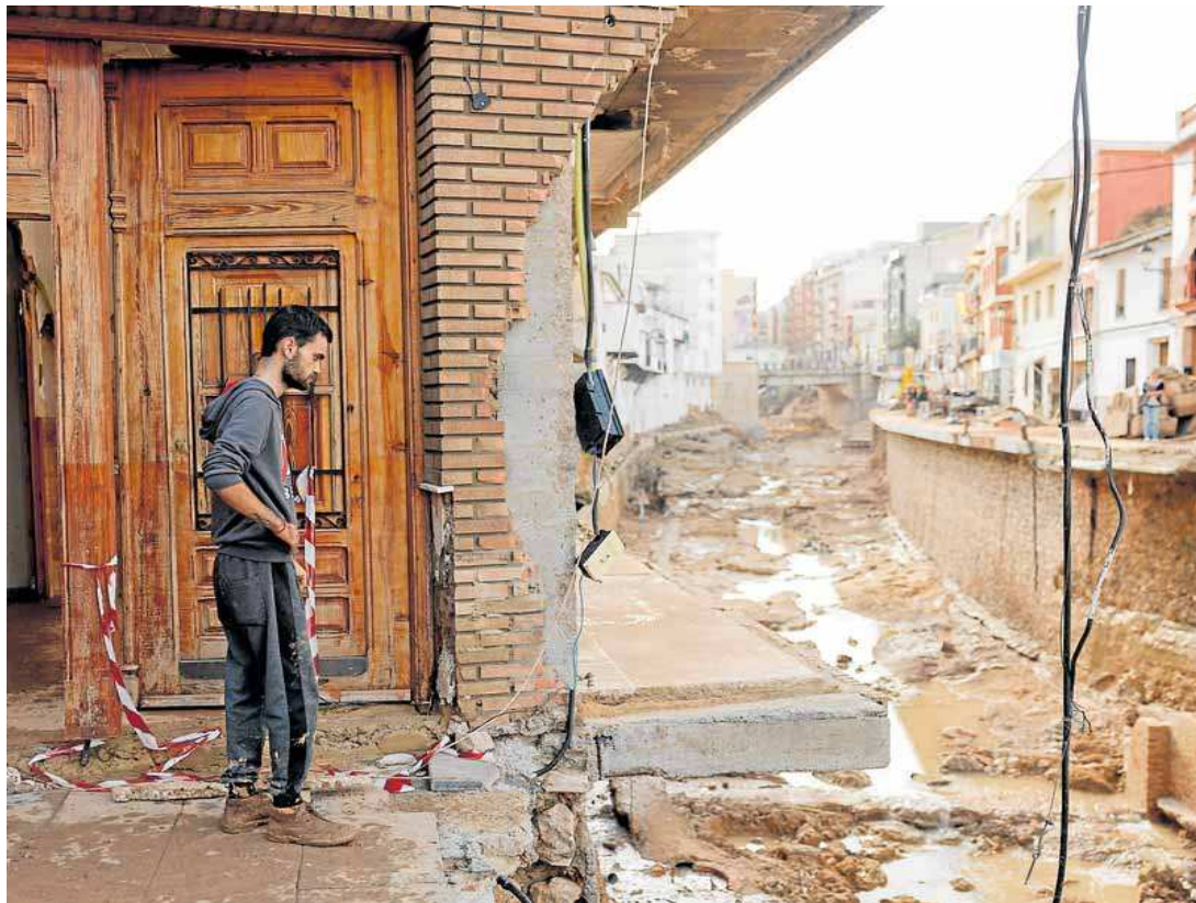
Un hombre observa el estado de su vivienda y del barranco en Chiva. EFE/KAI FÖRSTERLING
